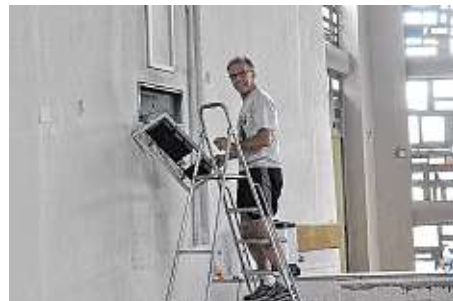
Demontage: Alles muss raus.
